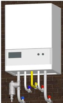
На рисунке изображен грязеуловитель установленный на вертикальном участке трубы. Такой способ подключения рекомендуется когда вы располагаете пространством по вертикали под котлом.
