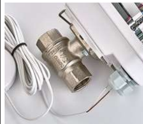
Фото 8. Завести провод датчика в кабельный ввод
